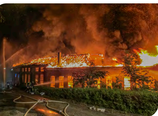
In der Nacht vom 31.5.2012, 00.30 Uhr brannte der historische Lokschiuppen am Bahnhof nieder. Der Einsatz dauerte ca. 30 Stunden. Ein Güterzug mit giftigen Pflanzenschutzmitteln musste aus unmittelbarer Bedrohungslage entfernt werden, um eine Katastrophe zu verhindern.
